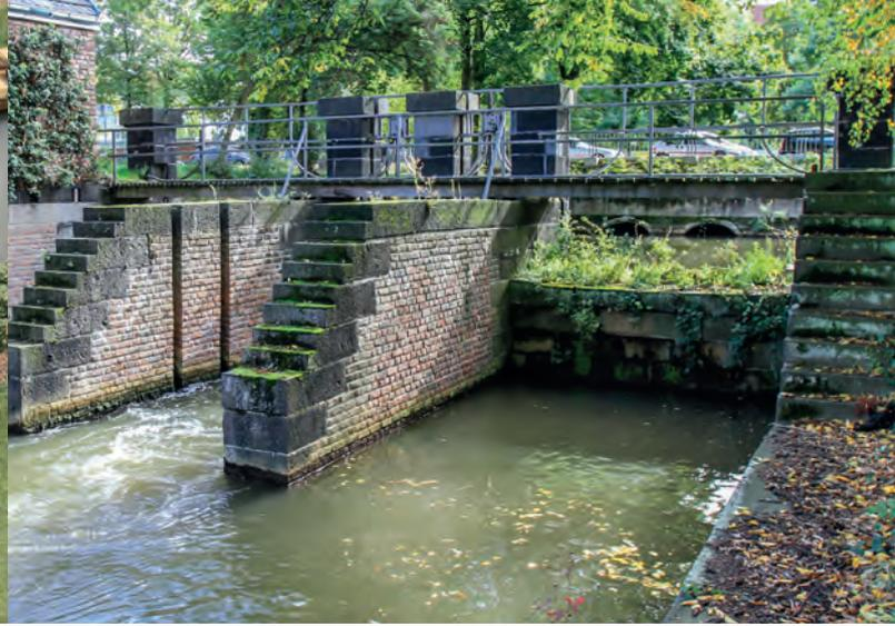
des Bauwerkes war es, das Wasser der Obererft das ganze Jahr über gleichmäßig, höhengleich und ohne Beeinträchtigung der Kanal-Schifffahrt in den Kanal einzuspeisen. Darüber hinaus musste sichergestellt werden, dass die Neusser Mühlen am Obertor noch mit genug Wasser versorgt blieben.
