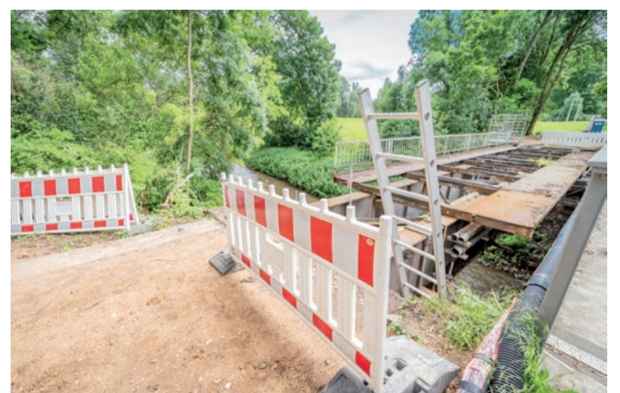
Radwegarbeiten an der Erftbrücke zwischen Grimlinghausen und Gnadental
